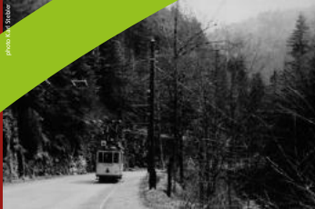
Une des dernières courses du tram, en 1949, dans les gorges du Seyon. Au milieu des gorges, la ligne à voie unique comportait un évitement pour permettre les croisements.
