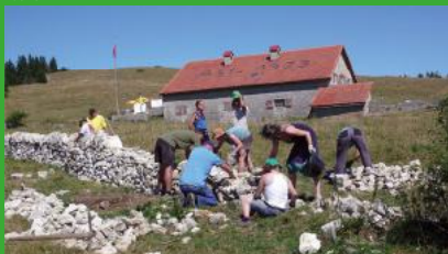
Entretien, réparer, reconstruire les murs de pierres sèches, précieux éléments du patrimoine naturel et paysager des crêtes: une des tâches périodiques des Amis du Mont Racine.
