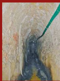
L'ancien aqueduc est en partie réutilisé aujourd'hui pour le transfert des eaux usées de l'ouest du Val-de-Ruz à Neuchâtel (conduite inférieure) et l'adduction d'eau potable à Hauteville (conduite supérieure). A gauche, vue avant l'installation des conduites, à droite vue actuelle.
