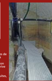
L'ancien aqueduc est en partie réutilisé aujourd'hui pour le transfert des eaux usées de l'ouest du Val-de-Ruz à Neuchâtel (conduite inférieure) et l'adduction d'eau potable à Hauteville (conduite supérieure). A gauche, vue avant l'installation des conduites, à droite vue actuelle.
